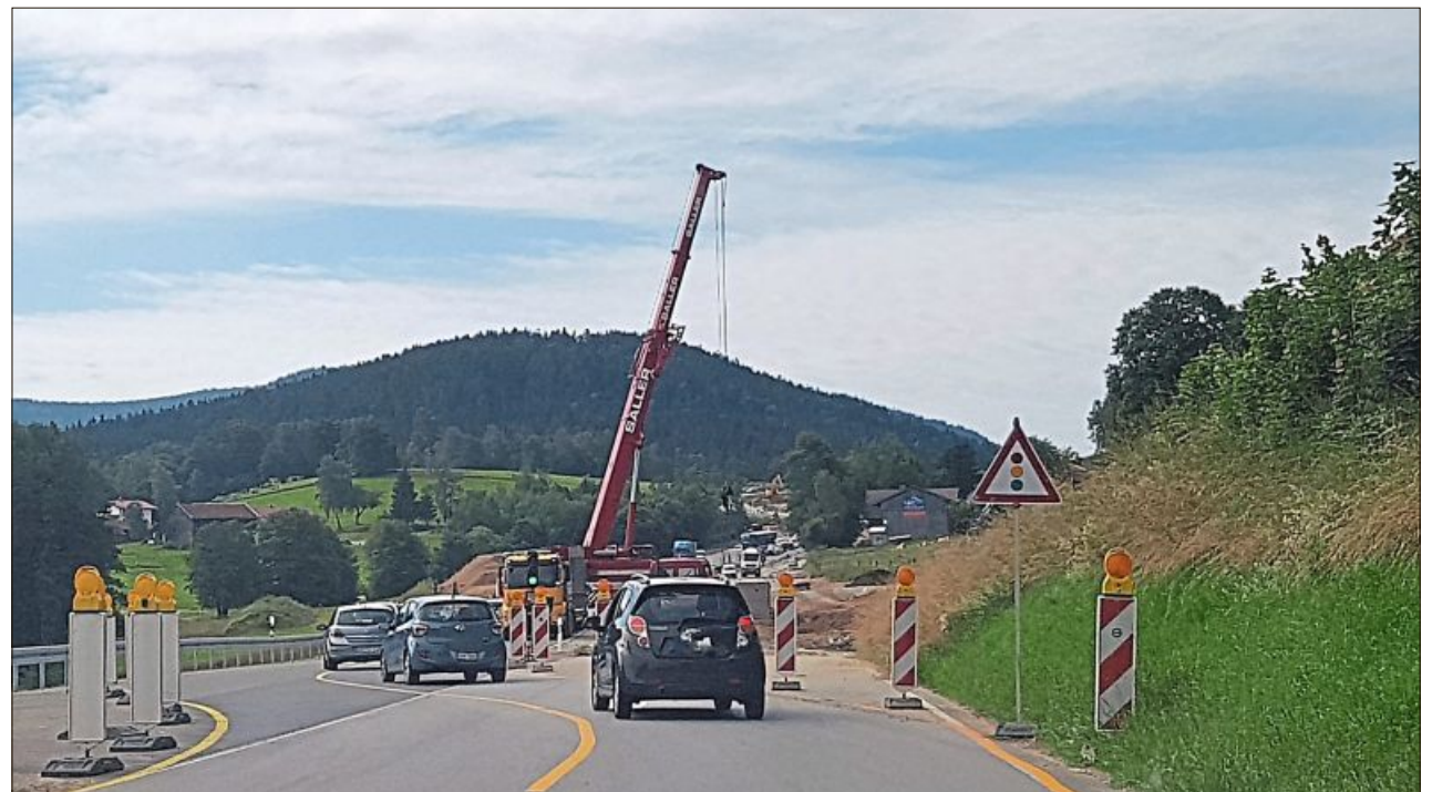
Ein Autokran unterstützt die Arbeiten an der Regenrückhalteanlage.
