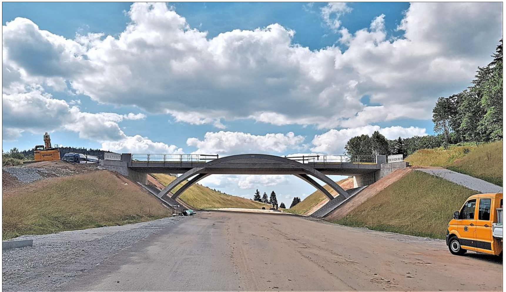
Das neue Brückenbauwerk am „Houbugl“, der höchsten Stelle der Ausbaustrecke, wirkt wie ein Tor zum Bayerischen Wald.
