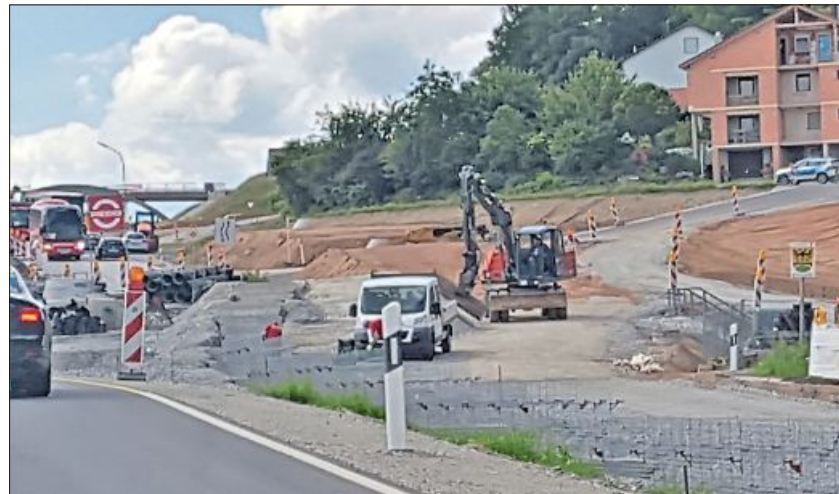
Der Bau der neuen Bundesstraße 11 an der Landkreisgrenze bei Hochbühl wird mit Hochdruck vorangetrieben. Foto: Peter Kallus
